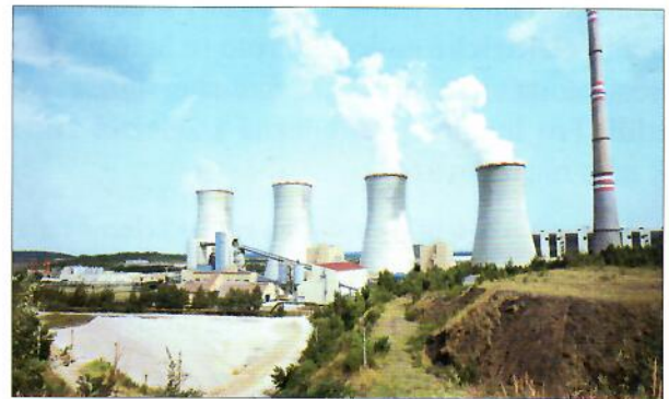
tepelná elektrárna (Chvaletice)
